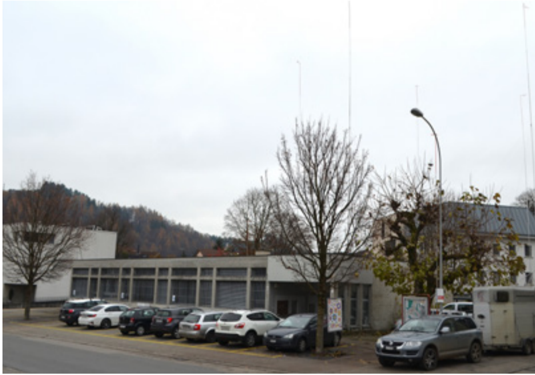
Bald Vergangenheit: Nun müssen das alte Postgebäude sowie das dahinterliegende ehemalige Gefängnis weichen. Der Polizeiposten wird aus dem Amtsgebäude in die neue Überbauung ziehen. Foto Ramon Juchli
