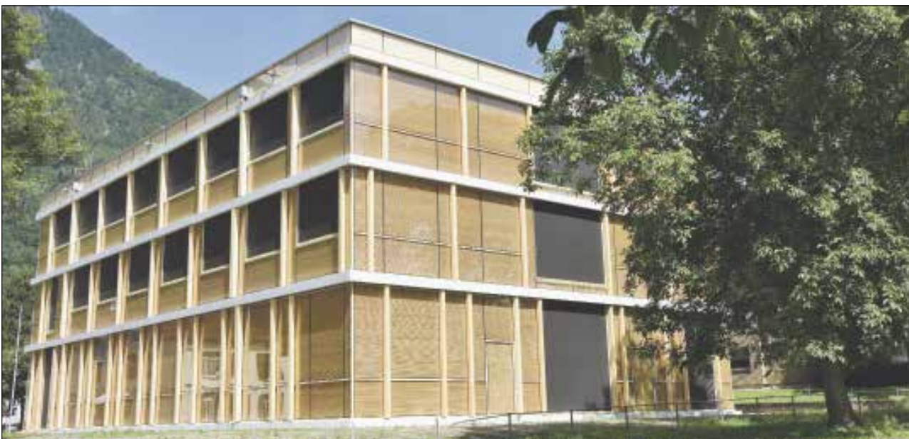
Glas und Holzlamellen bestimmen nicht nur die Optik des Erweiterungsbaus des BWZ Uri. Das System gewinnt dank seiner Konstruktion auch Sonnenenergie, die im Gebäude genutzt wird.
