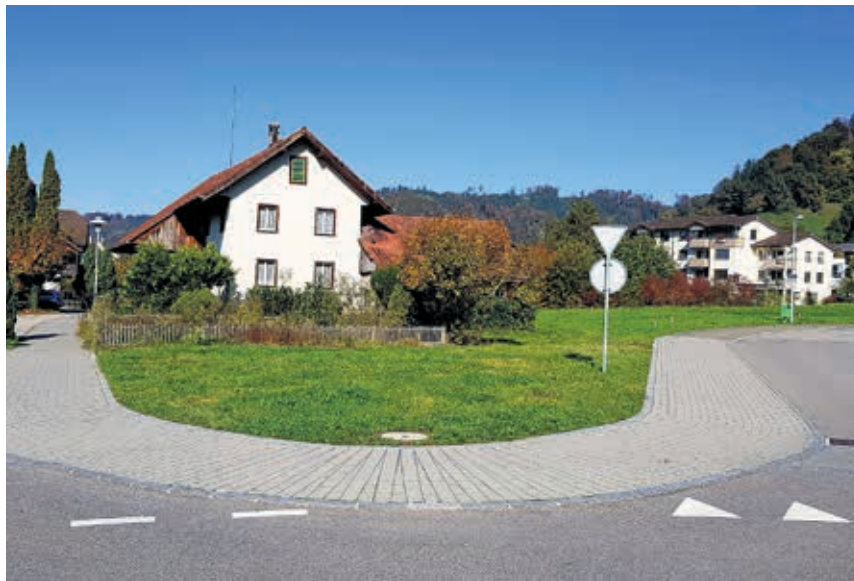
Das alte Bauernhaus im Burgfeld wird in den kommenden Tagen abgerissen ...
