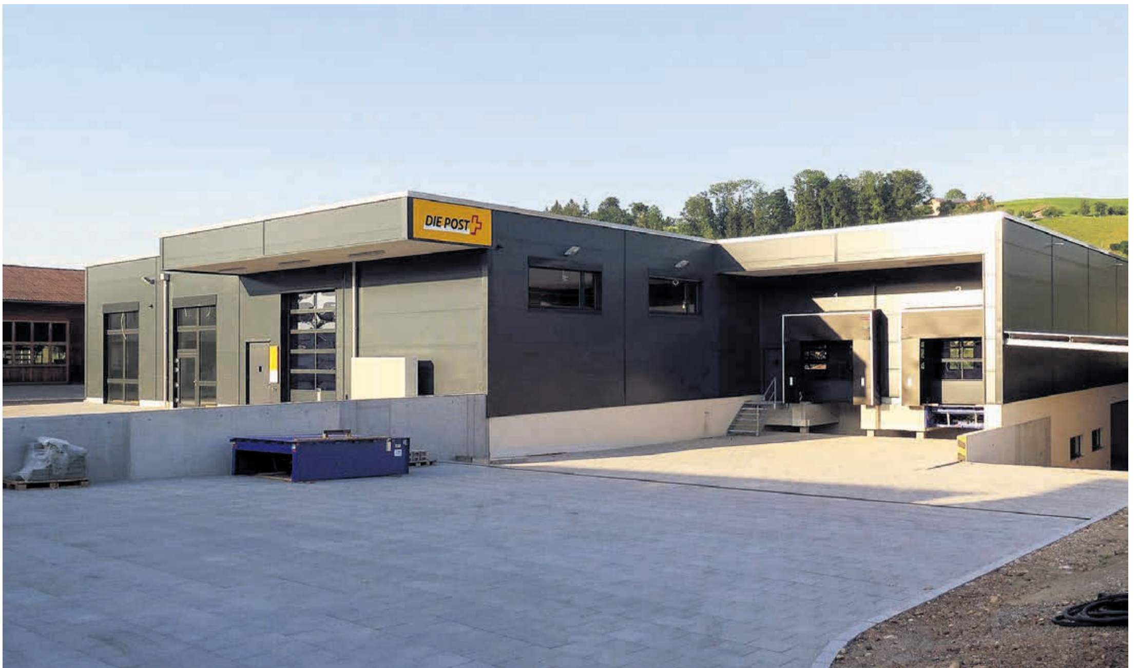
Im linken Teil des Gebäudes befindet sich die PostMail; über die Laderampe erfolgt per LKW die Anlieferung der Postpakete. Fotos zvg/CAS
