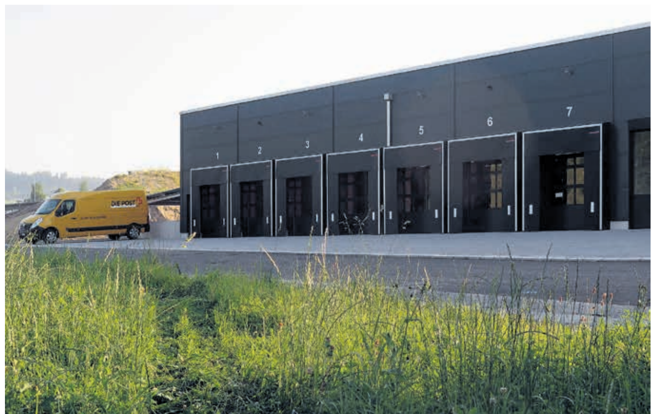
Hinter dem Erfolg von PostLogistics steckt minutiöse Planung, was sich auch im Äusseren des Gebäudes zeigt. An den Toren werden die Transporter mit Paketen beladen, von hier aus geht es auf die Zustelltour.
